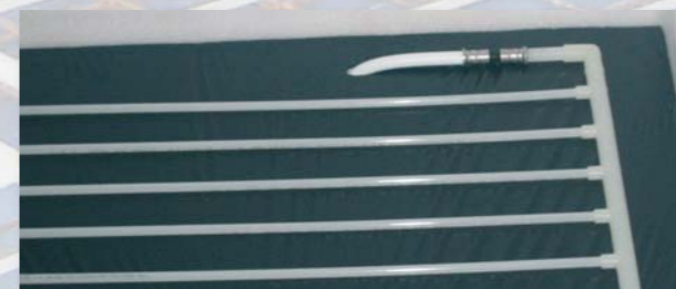
Anschluss mit Pressfitting
