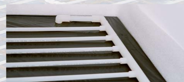
Anschluss mit Pressfitting
