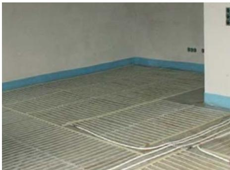
☺ Die **IHK® Fußbodenheizregister** in verschiedenen Größen werden diagonal miteinander zu den jeweils benötigten Heizflächen verbunden. Mit diesem System wird **Modulationstheorie (Verlegetechnik)** und **Tichelmann (Strömungstechnik)** erstmals **verbunden**.
